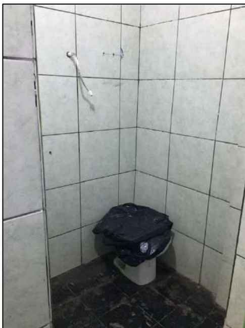
Figura 4 Banheiro da EEEM Guimarães Rosa
